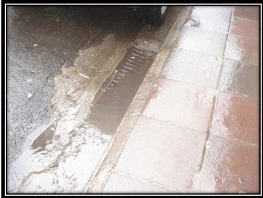
**Figura 9 Boca de Lobo com Grelha Entupida**
