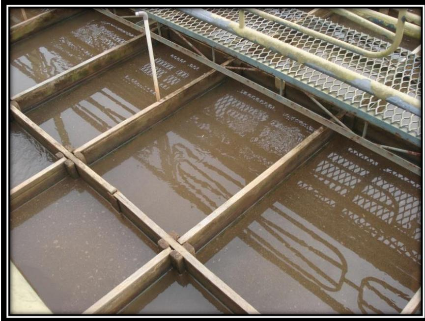
Figura 21: Floculador Hidráulico com Chicanas de Madeira
