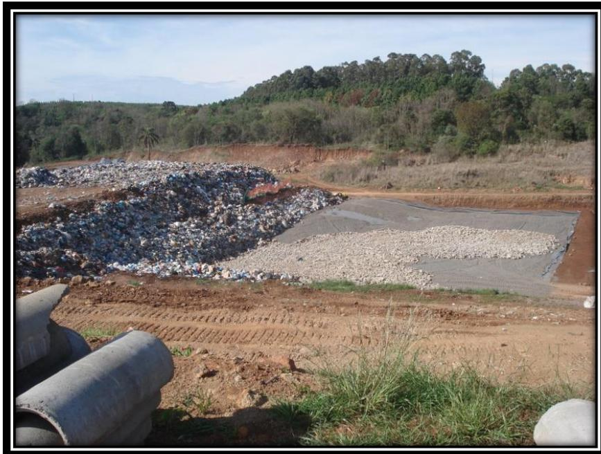
Figura 126 - Preparação Nova Célula
