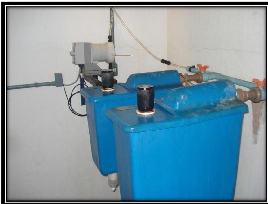
Figura 32: Dosagem de Coagulante (nível constante)
