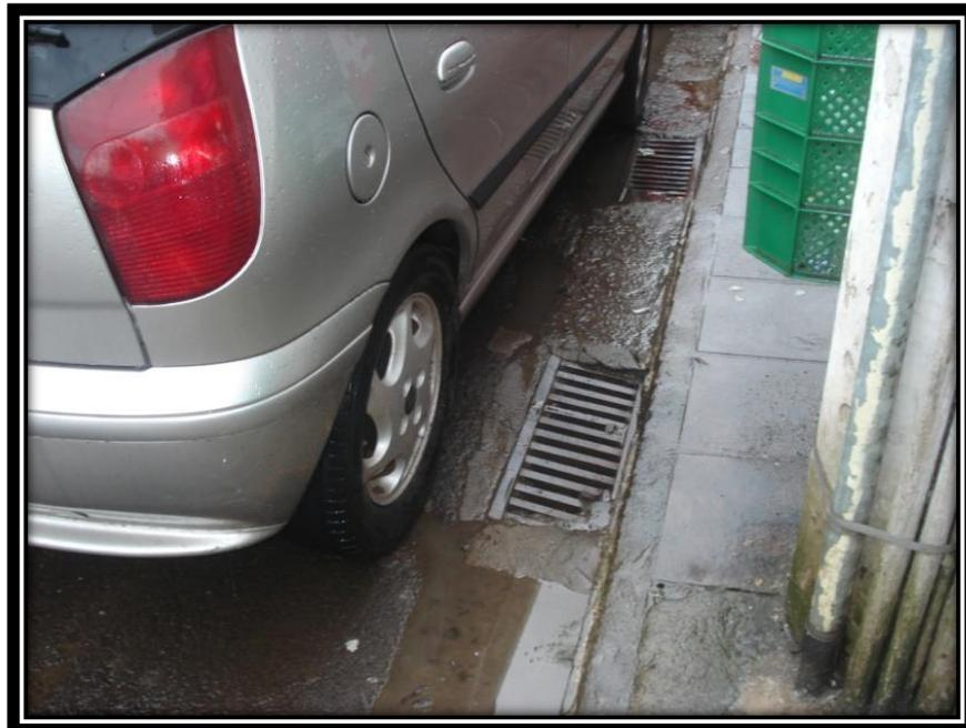
**Figura 8: Boca de Lobo com Grelha Metálica**
