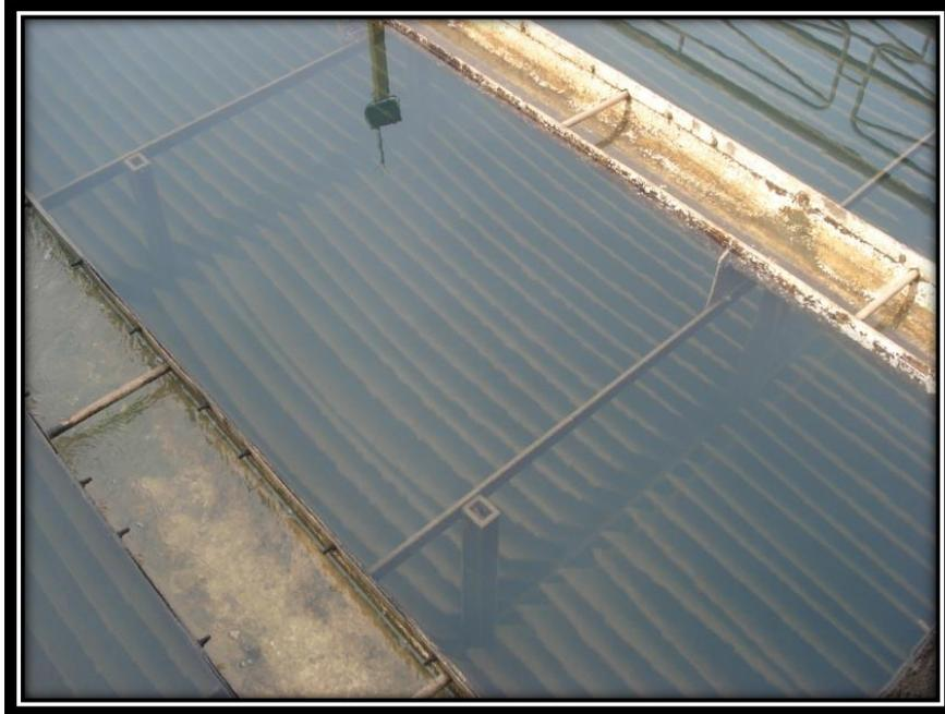
Figura 24: Decantador com Placas Decantação Acelerada
