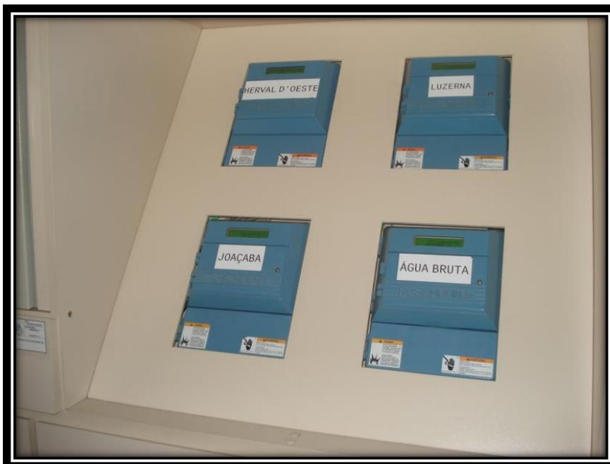
Figura 33: Registradores de Medidores de Vazão
