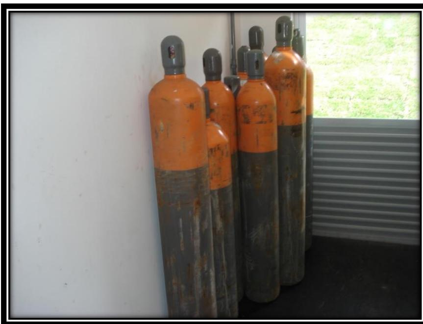
Figura 29: Estocagem de Cilindros de Gás Cloro
