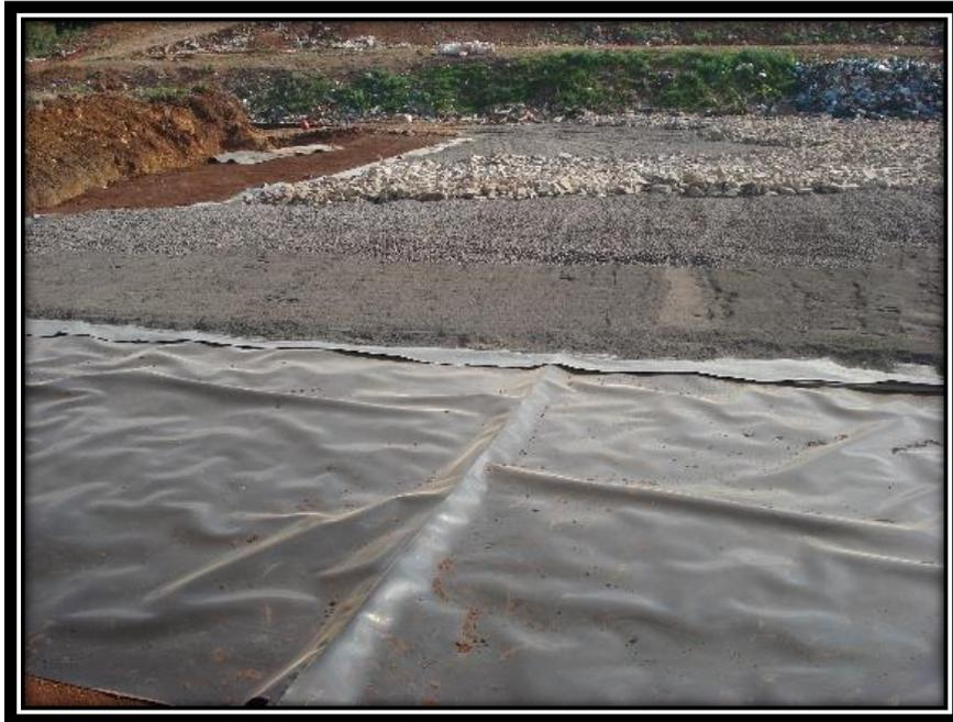
Figura 125 - Preparação Nova Célula
