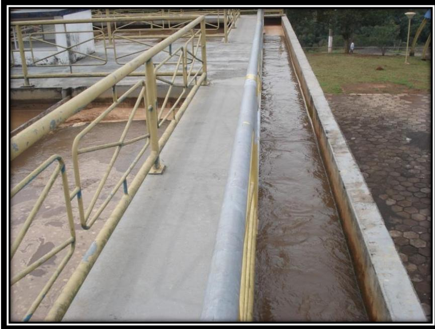
Figura 20: Canal de Água Coagulada
