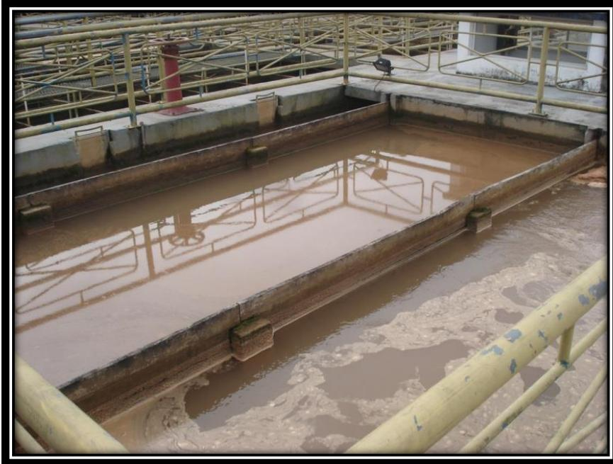
**Figura 22: Floculador Mecânico**
