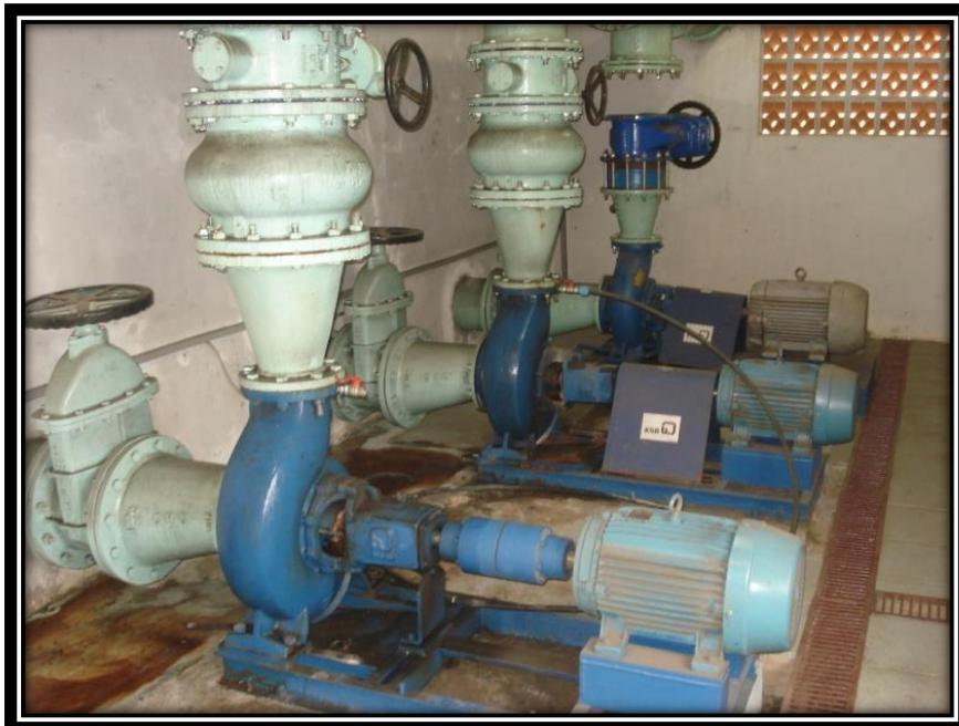
Figura 47: Elevatória de Água Tratada – EAT 001 Antiga CB 18
