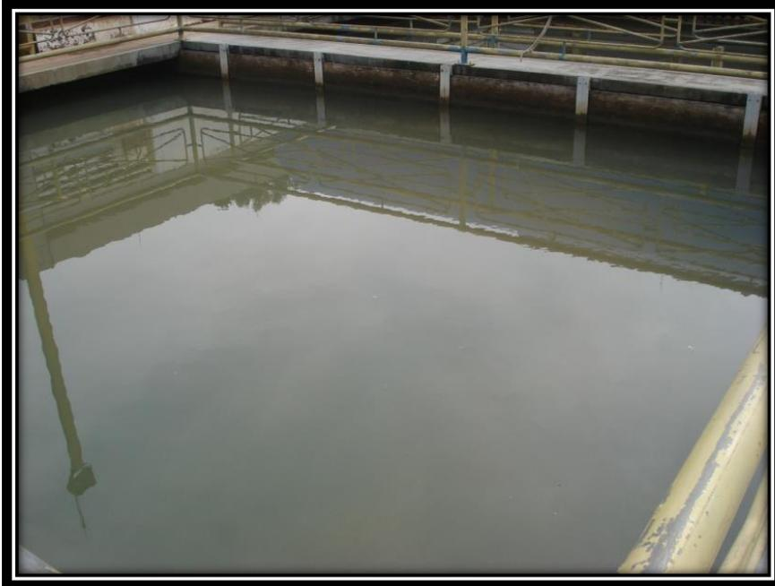
**Figura 23: Decantador Horizontal**
