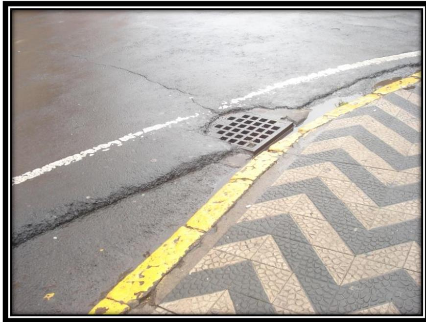
**Figura 114: Boca de Lobo com Grade Metálica**
