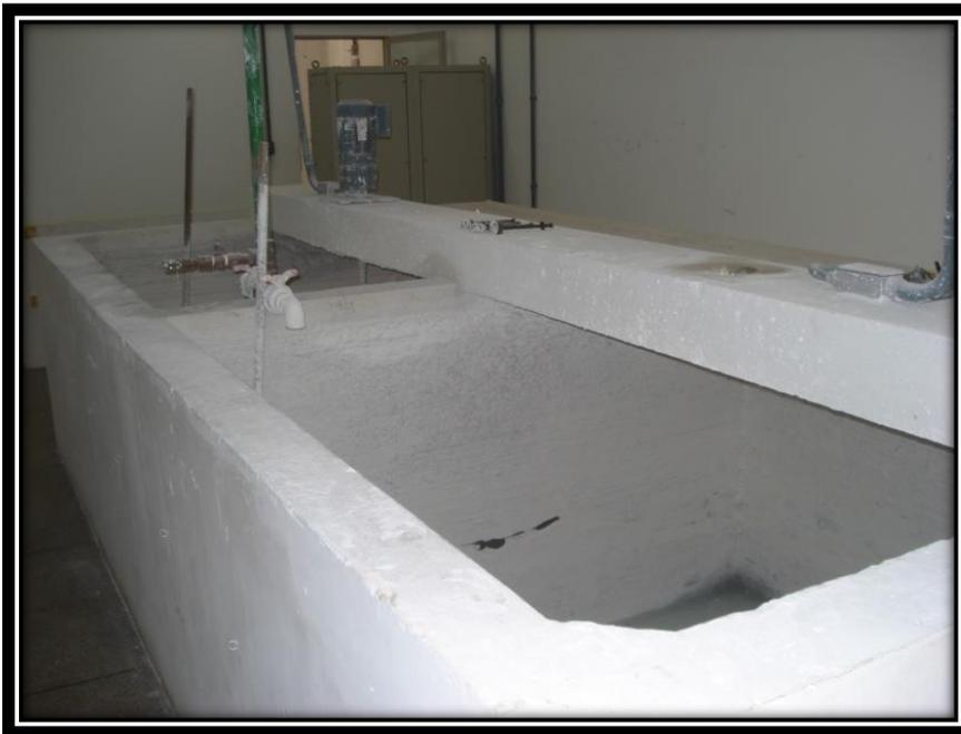
Figura 30: Tanque de Preparo de Solução de Cal
